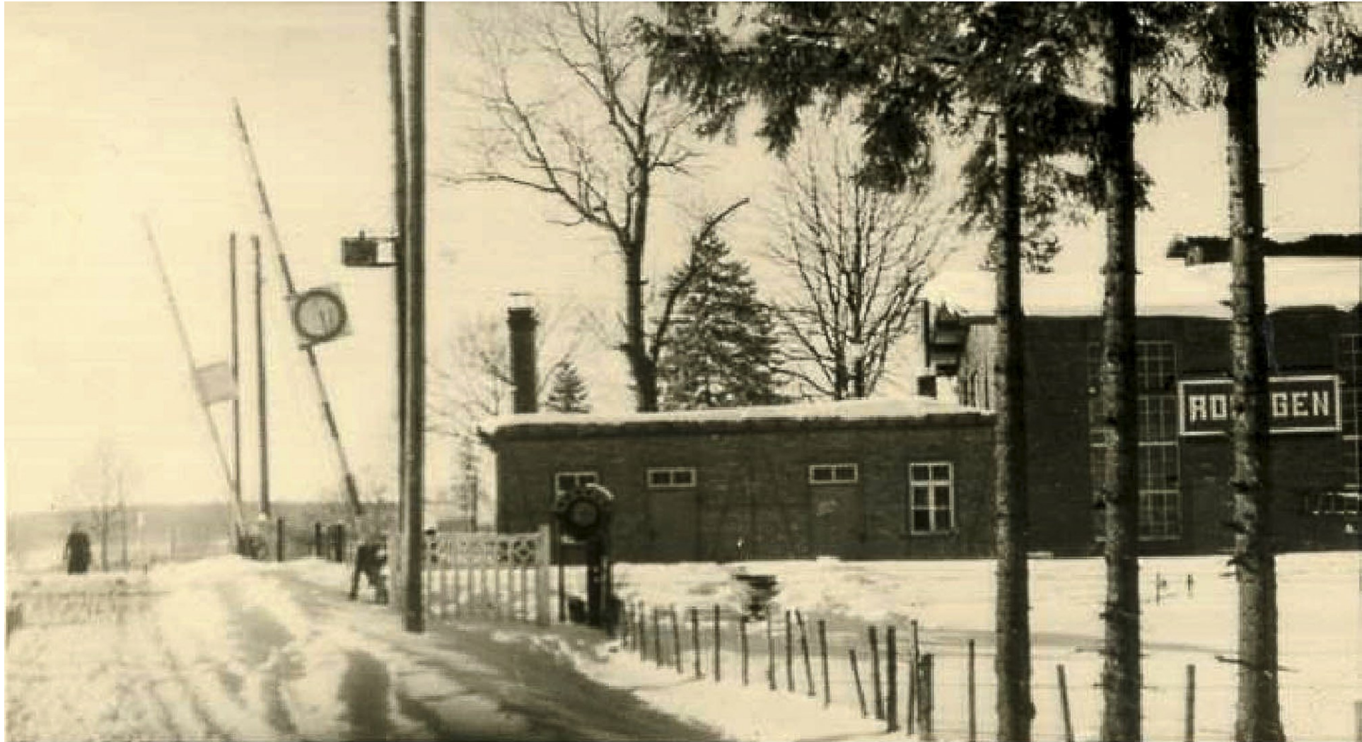
Der Lokomotivschuppen mit Signalmeisterei am Bahnübergang Mühlenstraße, um 1939 Sammlung Vennbahn
