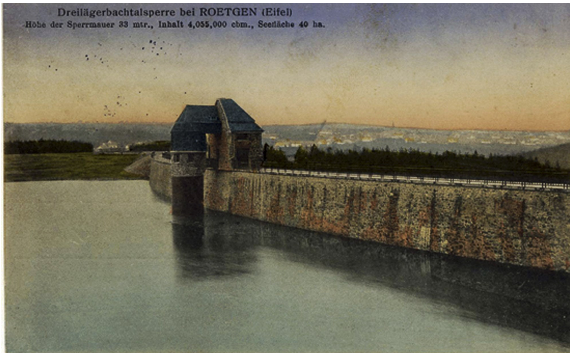
Die Mauer der Dreilägerbachtalsperre (colorierte Ansichtskarte mit Poststempel 24.09.1913)
