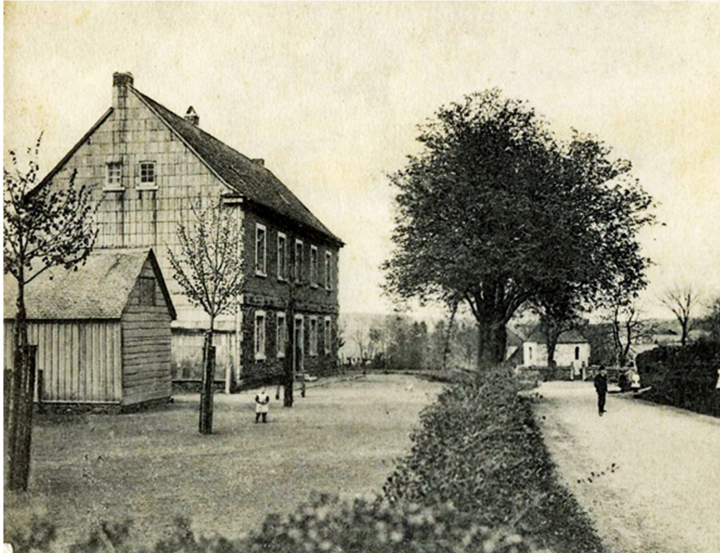
Hier auf dem Hof der Roetgener kath. Volksschule wurde 1848 der „revolutionäre“ Fahnenbaum errichtet. Das Foto vom Anfang des 20. Jh. zeigt den damaligen Zustand der Schule. Der Bau wurde 1828 begonnen. Das eingeschossige Haus hatte zunächst ein Strohdach. 1852 wurde der 2. Stock hinzugefügt. Es wurde vielfach umgebaut und erhielt nach und nach sein heutiges Aussehen. Im Hintergrund erkennt man die Marienkapelle.
