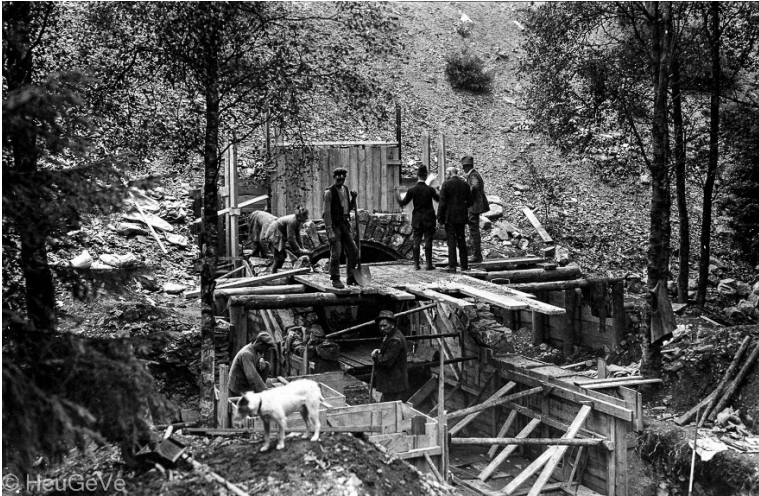
Am Auslauf des Tunnels in Roetgen/Dreilägerbachtalsperre
