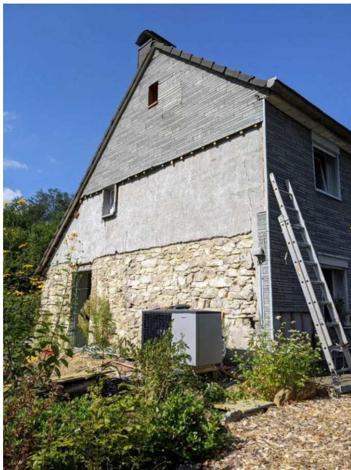
Kleiner Teilfortschritt: Freilegung der alten Bruchsteinwand.
